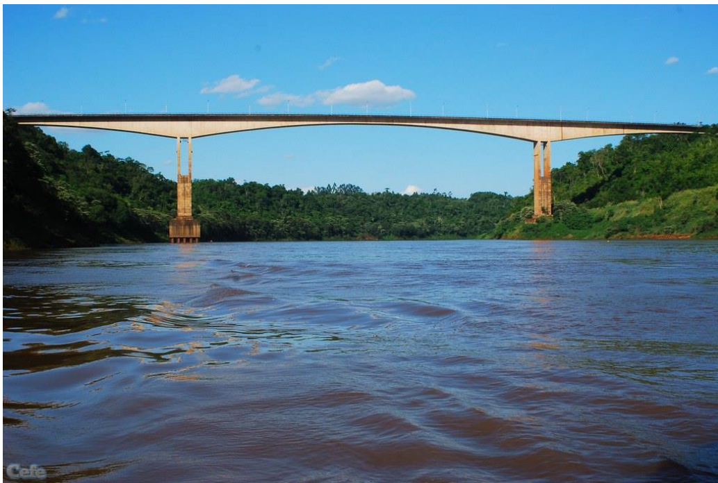
Puente Tancredo Neves
