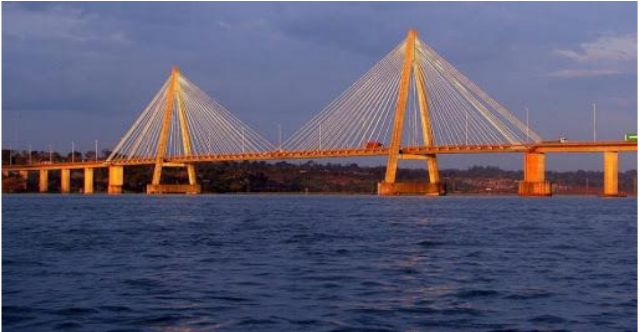
Puente Roque González de Santa Cruz
